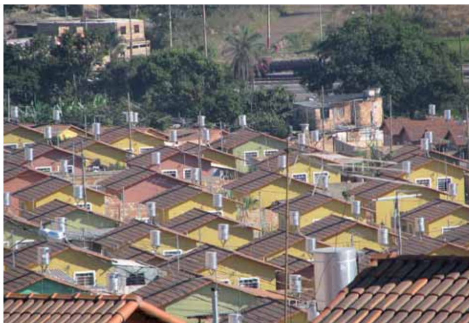
Aquecedores solares foram instalados em casas do conjunto habitacional Dicalino Cabral em Betim
