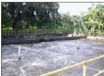
Figura 28: sistema de lodos ativados Fonte: Instituto AGIR Sustentável
