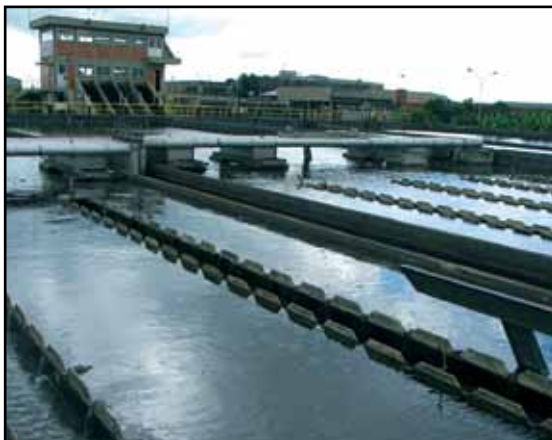
Figura 6: Tanque de decantação retangular Fonte: Instituto AGIR Sustentável
