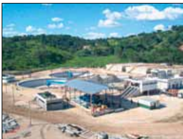
Figura 27: Vista geral da ETE Central em construção. Fonte: COPASA
