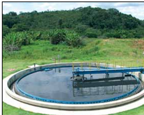
Figura 7: Tanque de decantação circular Fonte: Instituto AGIR Sustentável
