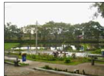
Figura 30: lagoas de estabilização com vegetação. Fonte: Instituto AGIR Sustentável
